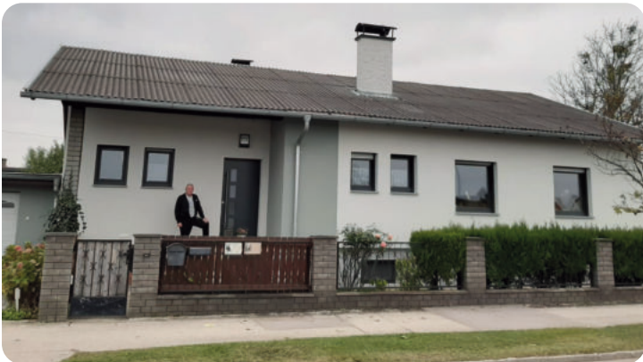
Gerhard Kiraly vor seinem sanierten Haus
